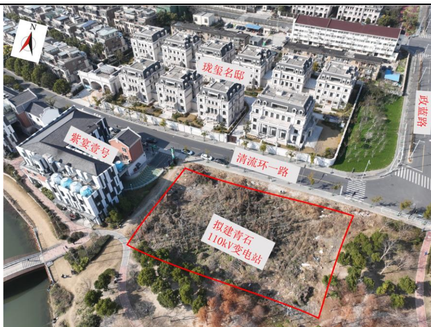
图 2.2-1 青石 110kV 变电站站址现状
