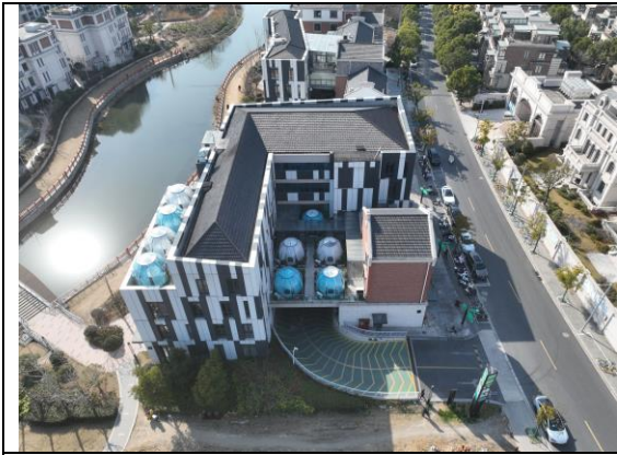
站址西侧现状
