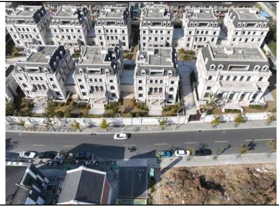
站址北侧现状
