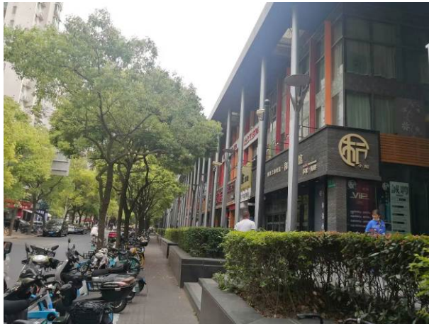
建筑南侧沿街商业建筑
