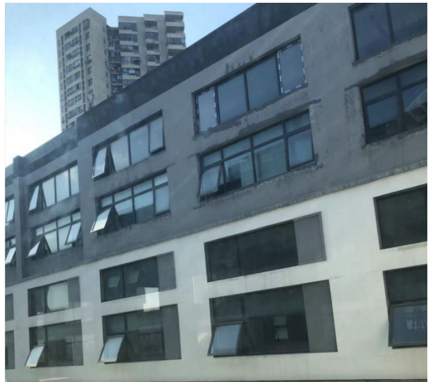
北侧为 4 号楼北侧
