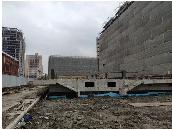
昆明站基础底板北侧拍摄
