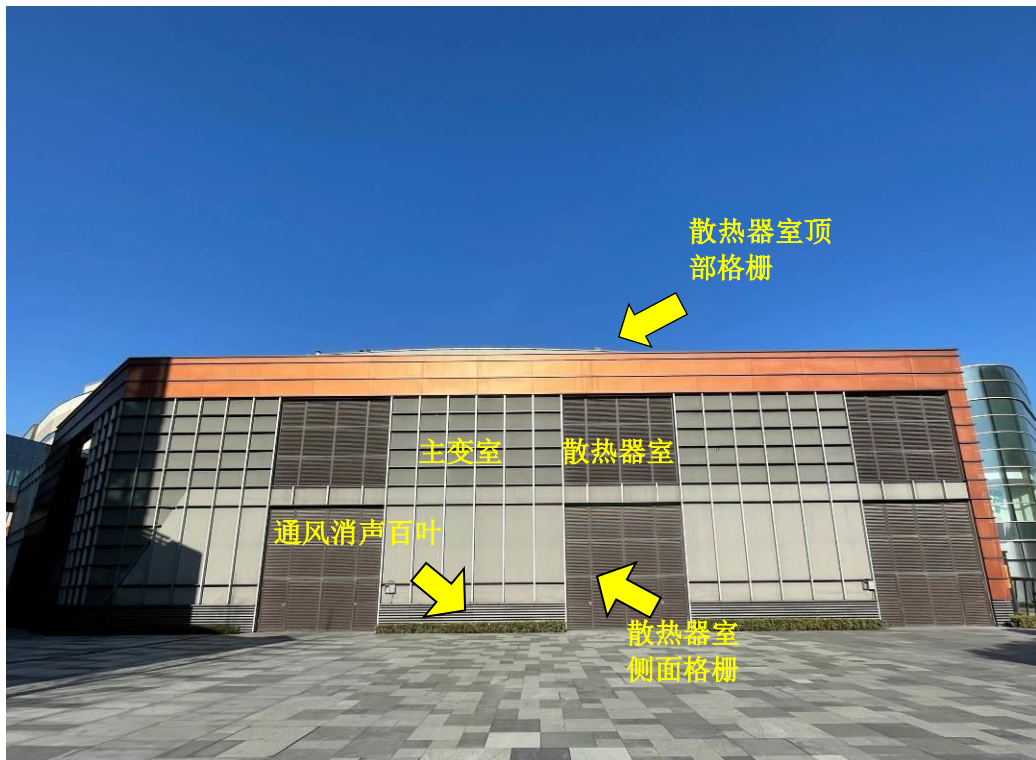
图 4.4-1 类比工程主变及散热器布置方式示意图
