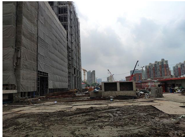
昆明站北侧空地及物料存储间
