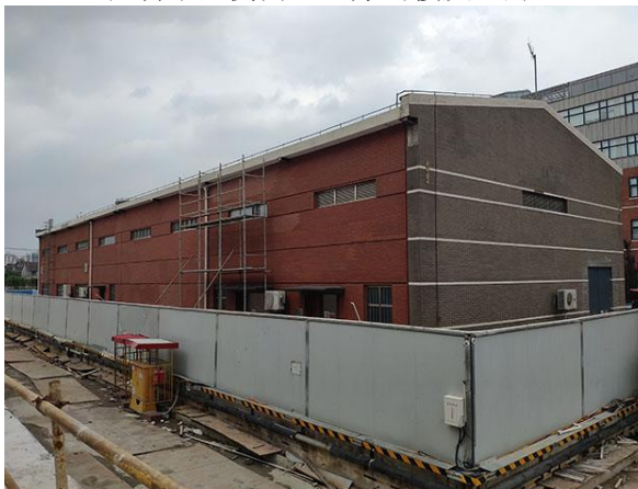
昆明站东侧 35kV 变电站
