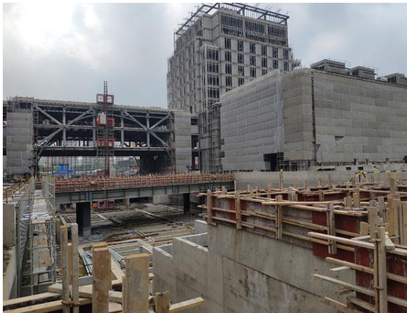
昆明站西侧商业、办公楼及连廊
