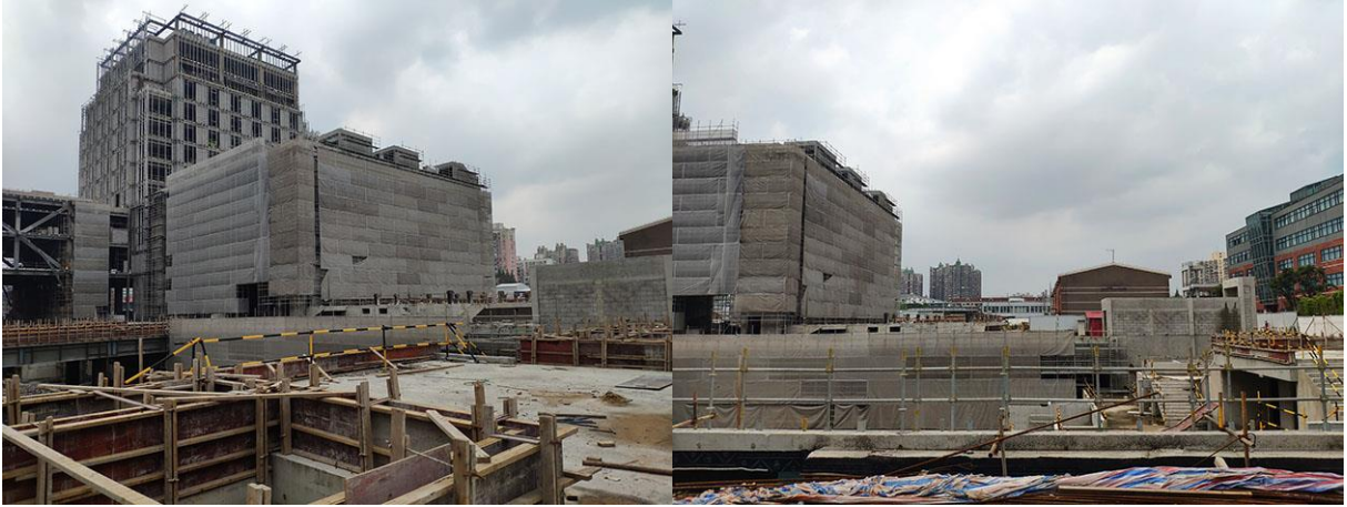
昆明站西侧商业及办公楼
