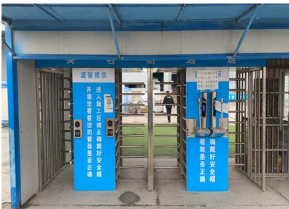
图 8 工地副门设置
