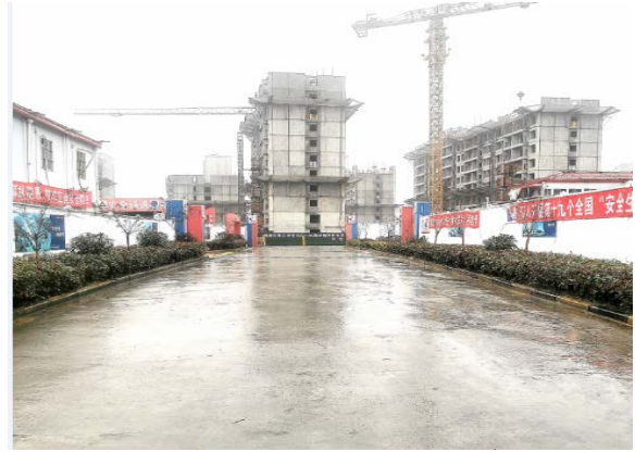
图 15 现场道路场地硬化
