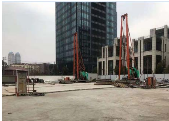
图 17 钻孔灌注桩施工场地硬化
