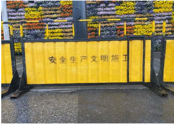
图 5 市政工程定型化施工路拦
