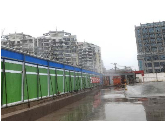
图 18 围墙喷雾降尘装置
