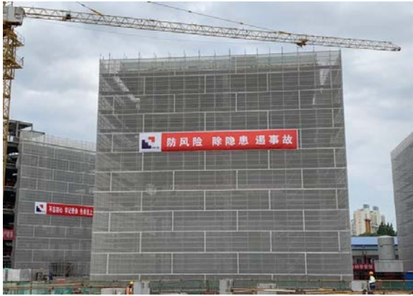
图 14 承插型盘扣式钢管脚手架
