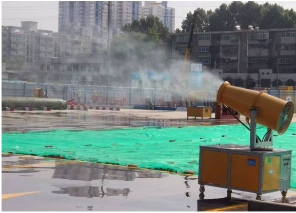
图 20 移动式抑尘装置
