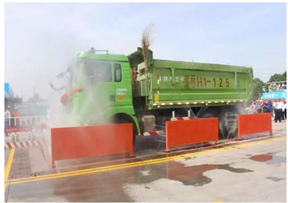
图 12 车辆冲洗装置设置
