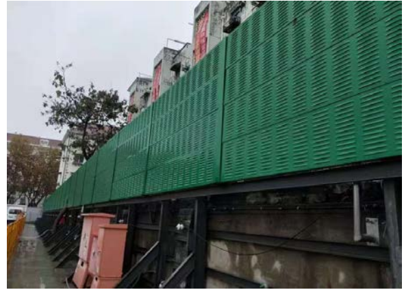
图 23 隔声屏障设置
