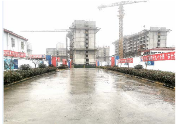
图 15 现场道路场地硬化
