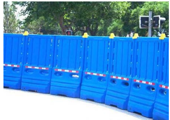
图 4 市政工程定型化可移动围挡
