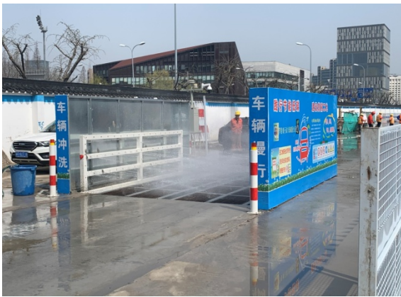
图 12 车辆冲洗装置设置
