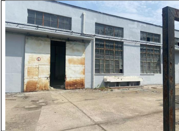
厂房正门（南侧）
