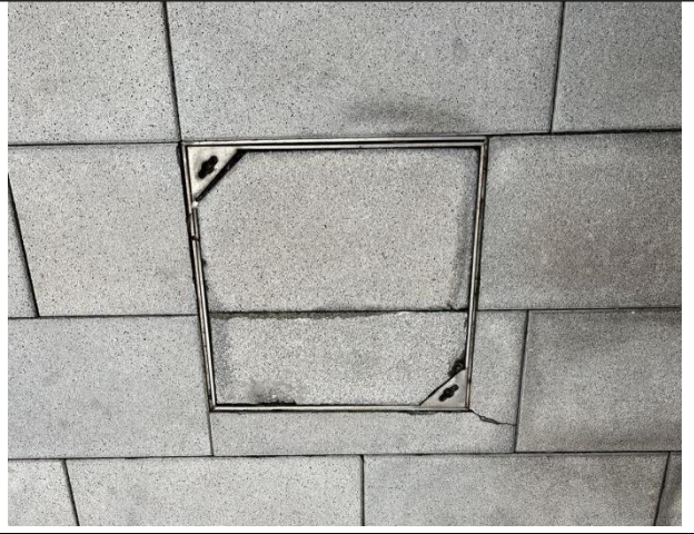
DW002 生活污水排口
