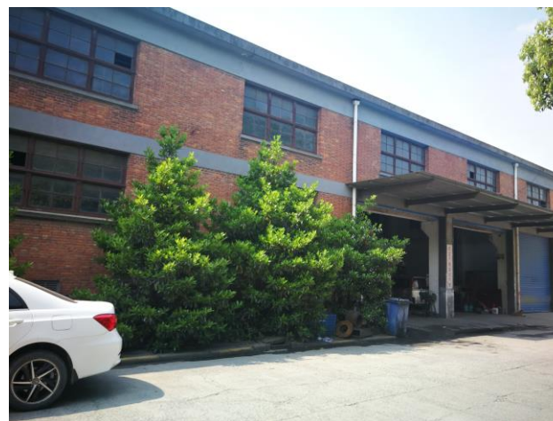
东侧的上海乾通发展有限公司机修间
