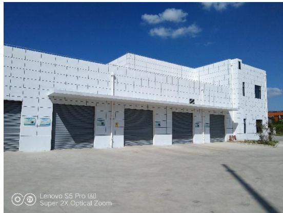
本项目所在建筑
